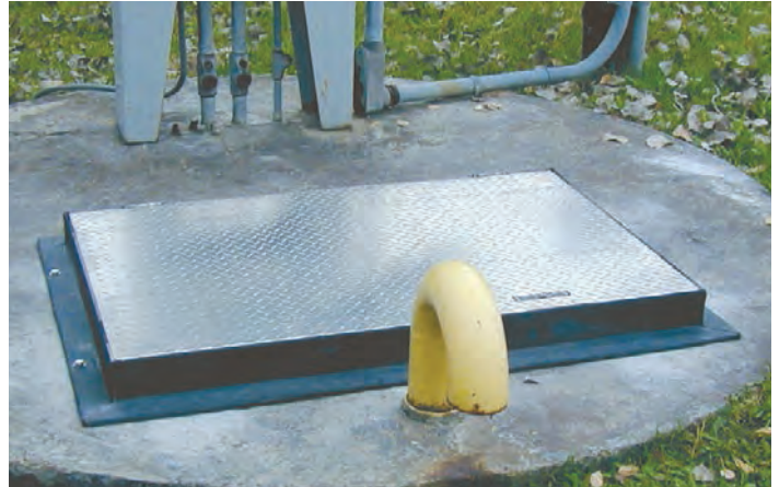
Tapa de 1/4" placa de aluminio anti deslizante con las bisagras de acero inoxidable.
