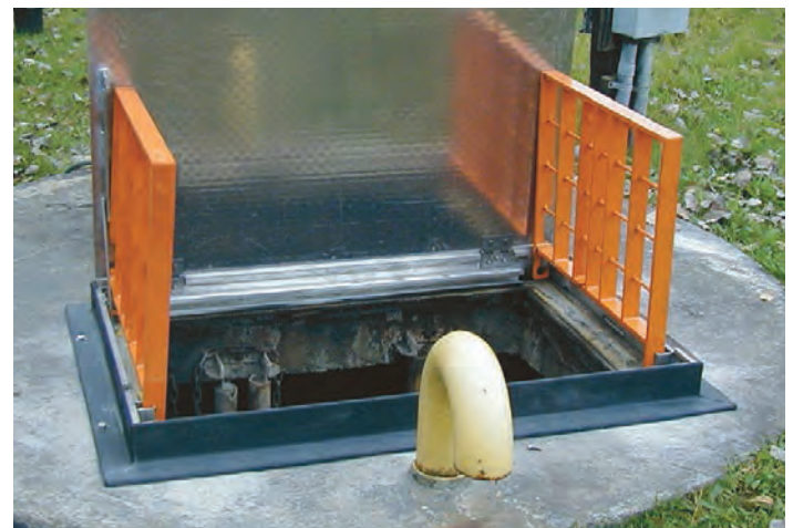
Rejillas de seguridad abiertas Rejillas de seguridad de aluminio pintada naranja proveen un bloqueo visual alrededor el hoyo
