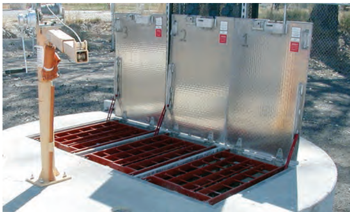
Rejillas de seguridad abiertas Rejillas de seguridad de aluminio pintada naranja proveen un bloqueo visual alrededor el hoyo
