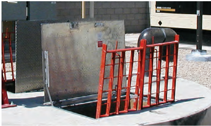
Rejillas de seguridad cerradas Rejillas de seguridad de aluminio pintada naranja proveen 300 libras por pie cuadrada protección peatonal anti caídas
