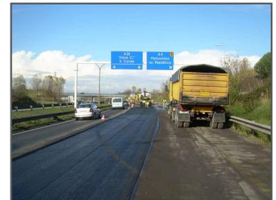
Se aplica en pavimentos asfálticos (flexibles) sobre antiguos pavimentos rígidos (placas de hormigón) o semirrígidos. Así mismo, es eficaz en la ampliación de vías.
